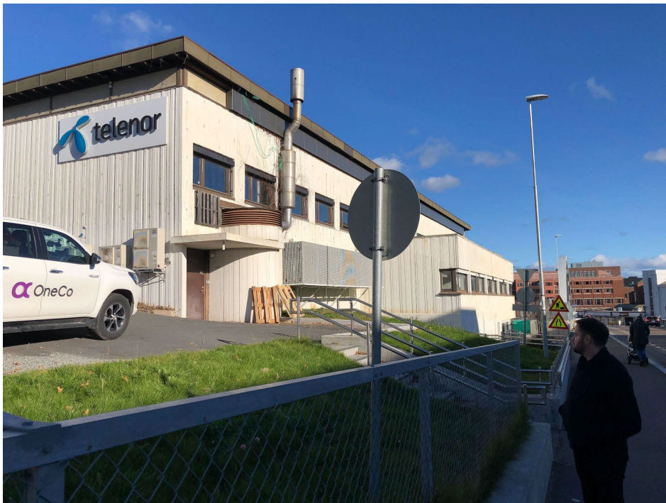
Bildet viser trappen fra Nordbyveien langs vestsiden av Telenorbygget
