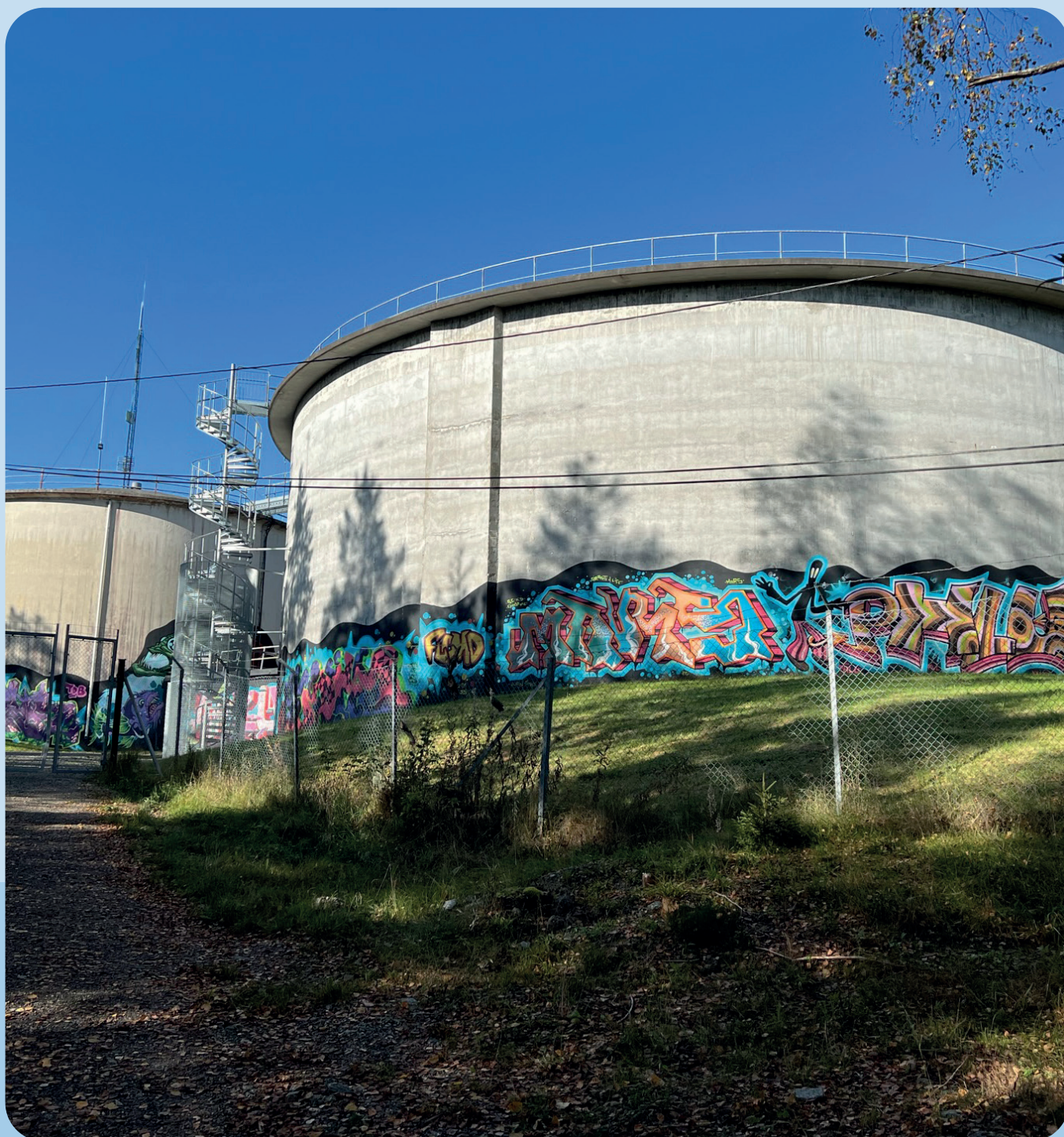
Vanntårnet Hebekk. Foto: Nordre Follo kommune
