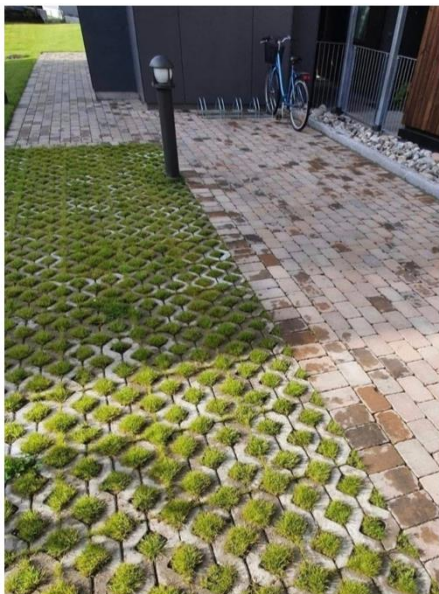
Eksempler på mindre blågrønne løsninger. Bilde til venstre: Gressarmeringsløsning, NorgesJord AS og bilde til høyre: Regnbed i privatbolig, Maskin og Utemiljø AS. Kilde: Overvannsveileder Morsa og Glomma sør
